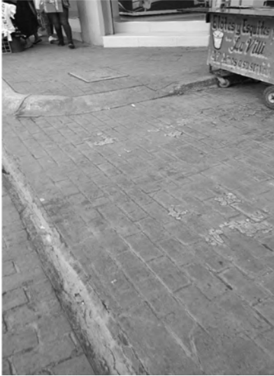
Imagen 3 Rampa en banqueta
