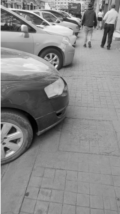
Nota: Vehículos invadiendo y reduciendo el área útil de banqueta
