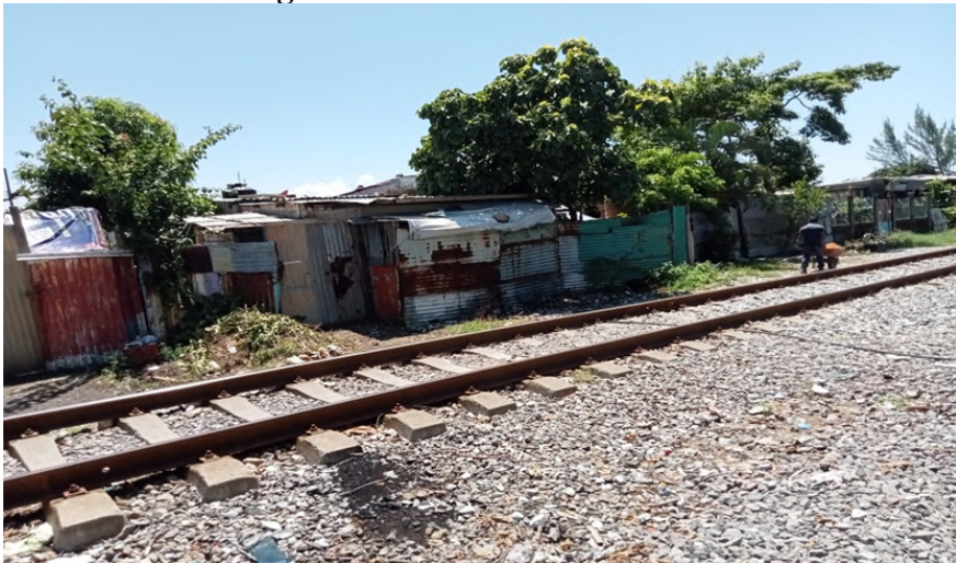
Figura 2. Vivienda en mal estado
